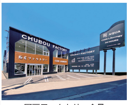
厨房ファクトリー全貌
