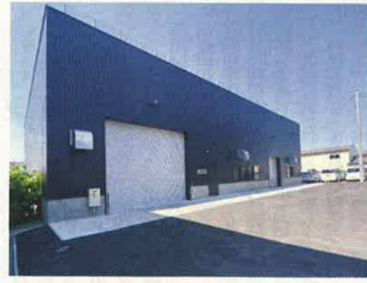
新設した第3倉庫概観
